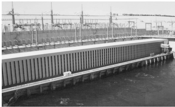
ГЭС Асуанской плотины.
